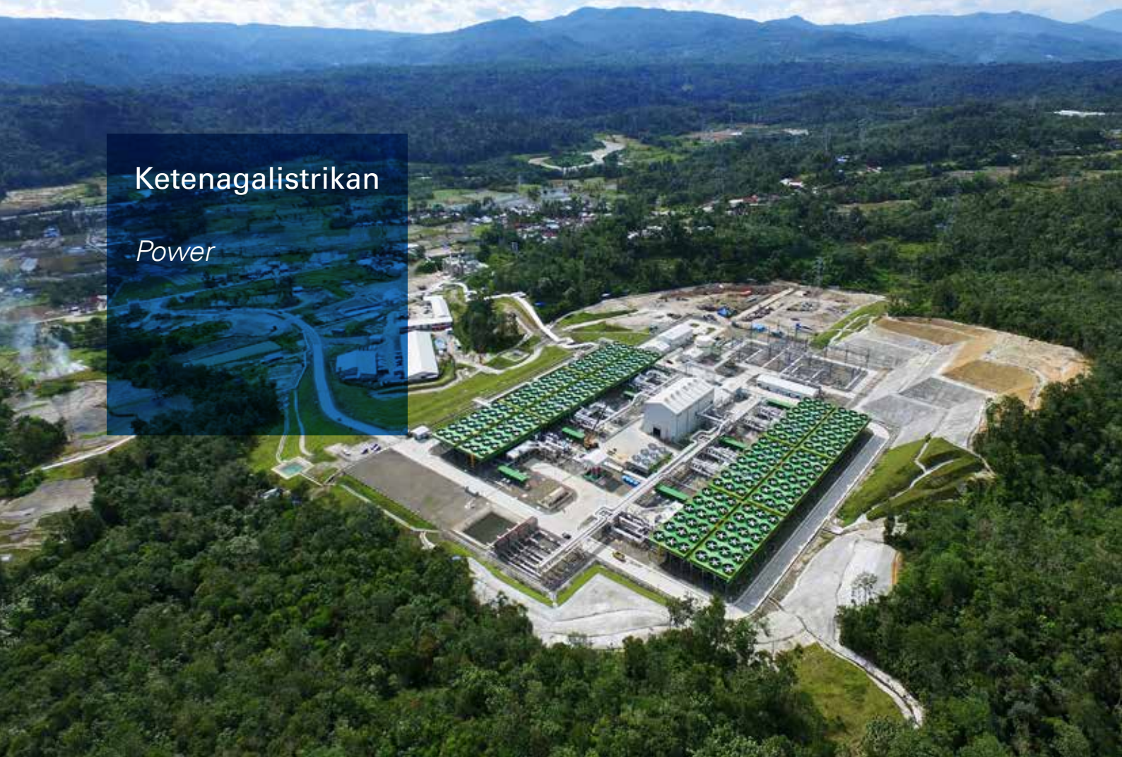
Pembangkit Listrik Tenaga Panas Bumi Sarulla sebesar 110 MV di Sumatera Utara, dioperasikan oleh Medco Power 110 MV Sarulla Geothermal Power Plant in North Sumatra, operated by Medco Power
