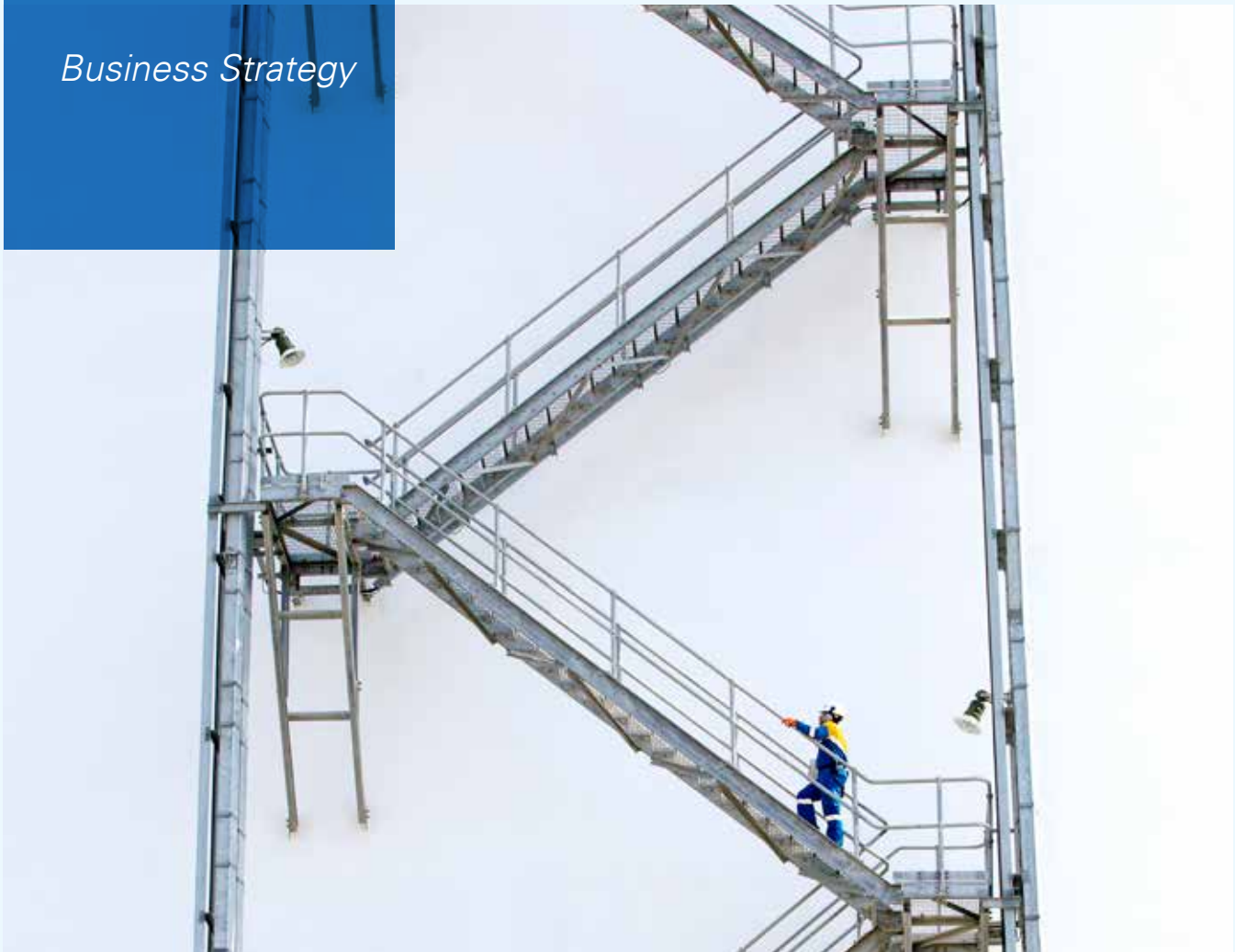
Karyawan DSLNG sedang melakukan inspeksi rutin pada tangki penyimpanan LNG DSLNG employee conducting routine inspection of an LNG storage tank
