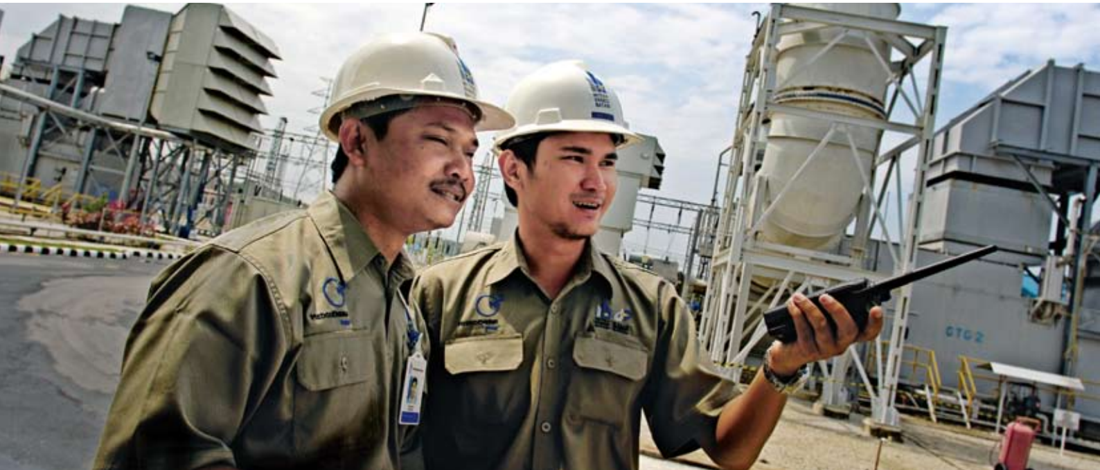
Pembangkit Listrik Tenaga Gas di Batam mendukung pemenuhan kebutuhan permintaan listrik yang terus meningkat di pulau tersebut.
