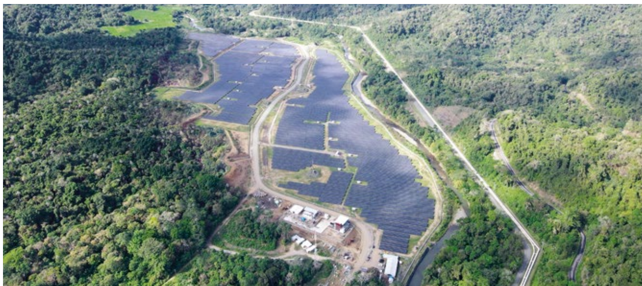
Fasilitas Sumbawa PV, Nusa Tenggara Barat, Indonesia
