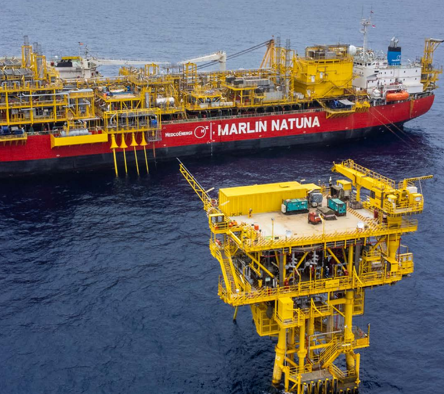
Platform Forel dan FPSO Marlin Natuna, South Natuna Sea Block B, Kepulauan Riau, Indonesia
